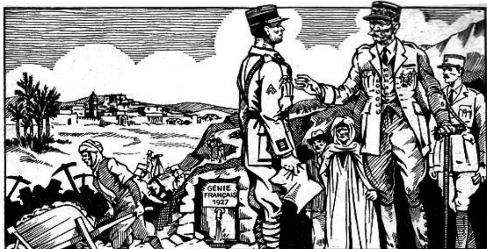
Le maréchal Lyautey surveille la construction d'une route.
